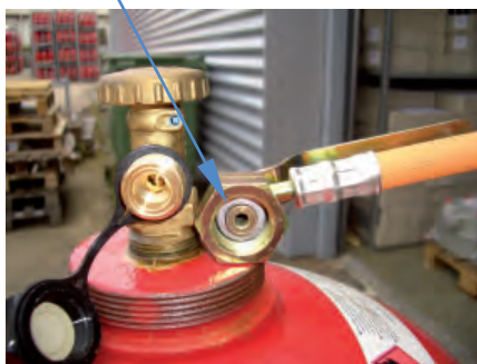
Abb. 15: Absperrventil 33-kg-Flasche und Hoch- druckschlauch mit Dichtung aus Aluminium
