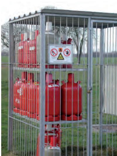
Abb. 46: Odrnungsgemäßes Lagern im Freien
