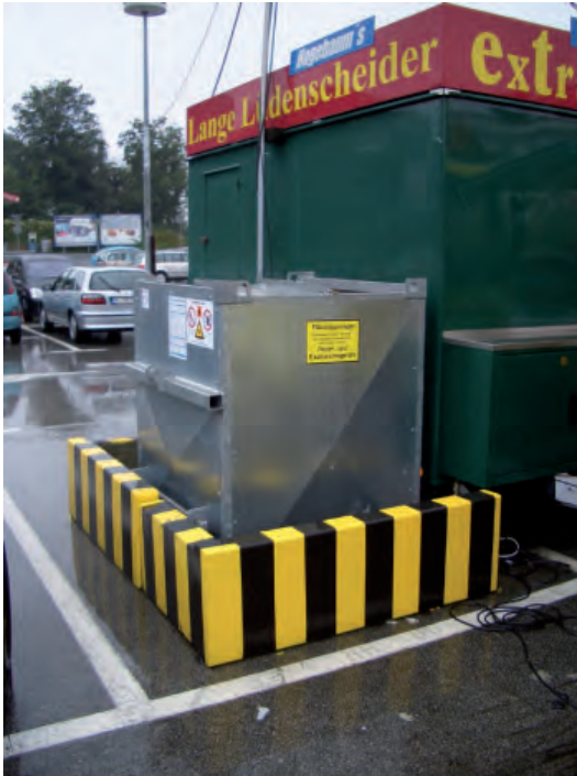
Abb. 49: Flüssiggas-Fass mit Schutzmaßnahmen (z. B. Anfahrschutz, Flaschenschrank)
