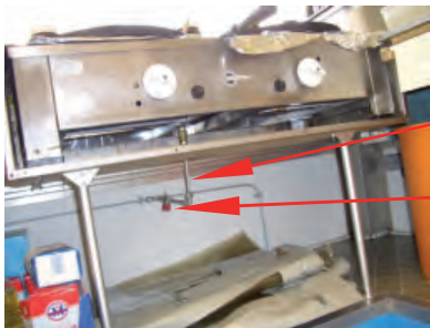
Abb. 18: Crêpe-Backgerät mit Anschluss an eine Rohrleitung und Absperreinrichtung
