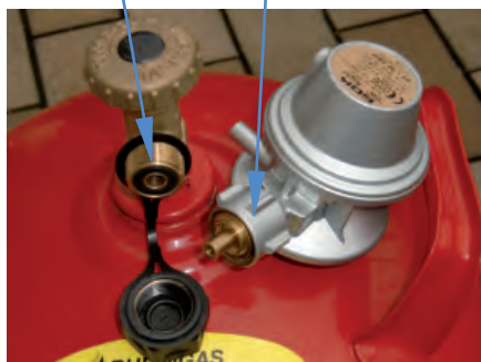
Abb. 14: Absperrventil 11-kg-Flasche mit Gummidichtring im Entnahmestutzen und Druckregelgerät
