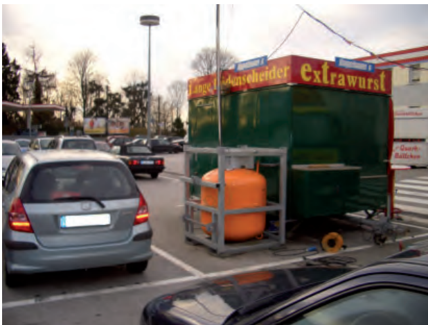
Abb. 48: Beispielhaftes Flüssiggas-Fass (hier: Fass mit einem Füllgewicht von 320 kg → ca. 10-fache Kapazität einer 33-kg-Flasche) mit fehlendem Anfahrsschutz sowie Schutzbereiche nicht eingehalten
